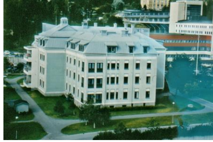
Andra lasarettet, s.k. Hus 5, under byggnation och färdigbyggt 1907.
